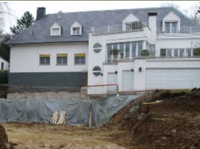
Für den Anbau grub sich der Bautrupp rund sechs Meter tief in die Erde.
